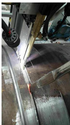
图 5：现场环缝焊接过程
